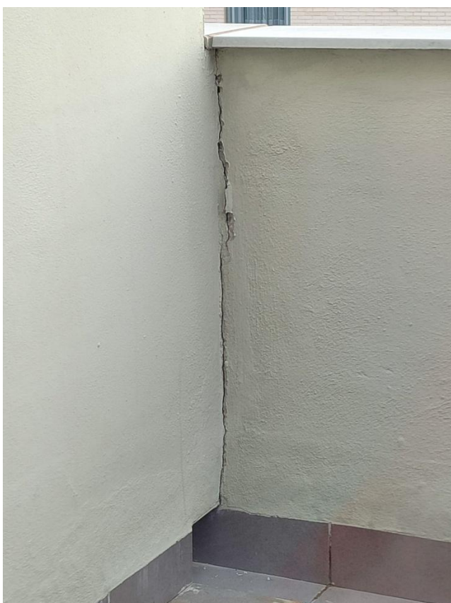
Imagen durante la construcción de los balcones P.Marta Mara, 8 con grietas actualmente.
