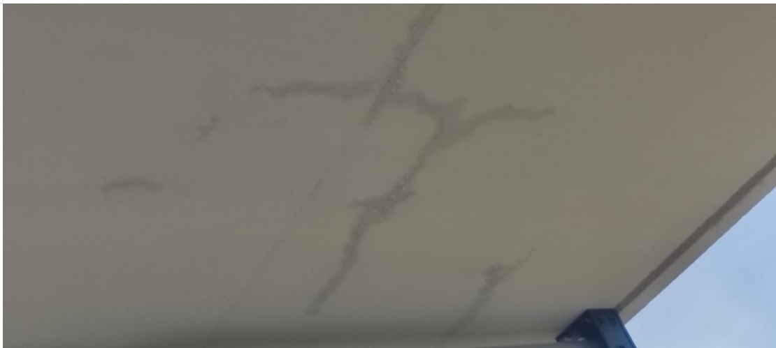
Techo terraza bloque 24 2A
