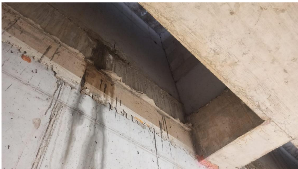
Goteras diversas en el garaje
